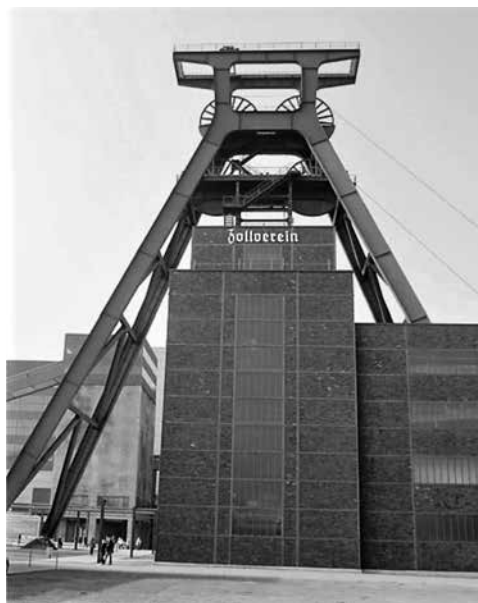
Pozo minero en Essen
