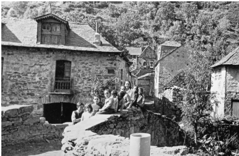
Puente de Colinas del Campo
